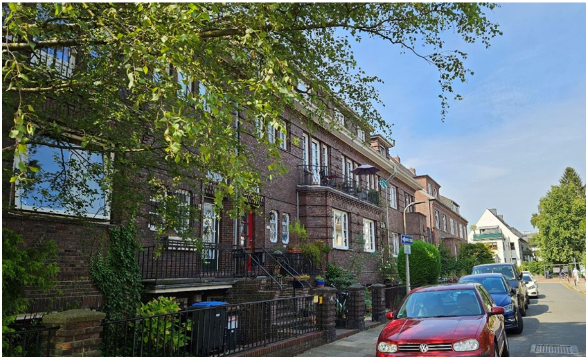
Abbildung 4: Backsteinfassade mit horizontalen Klinkerreliefs
